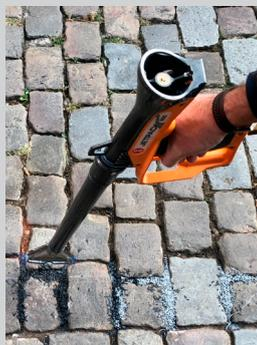
Appliquez une couche de ChipFill™ (épaisseur 15 mm max). Chauffez ChipFill™ qui se liquéfie, devient noir et épouse les contours du joint. Renouvelez l'opération si besoin jusqu'à ce que le joint soit comblé.
