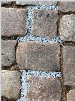
Nettoyez les joints et préchauffez le support à l'aide d'un chalumeau au gaz propane. Le joint ne doit pas excéder 45 mm de profondeur.
